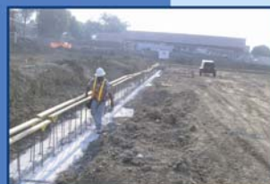
Offut AFB Construction
